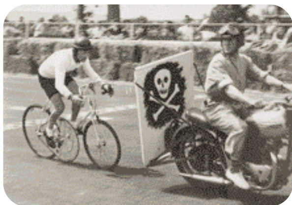
▲ Pour dépasser les 200 km/h, José Meiffret utilisait un pignon de 15 dents associé à un plateau de 130 dents !
